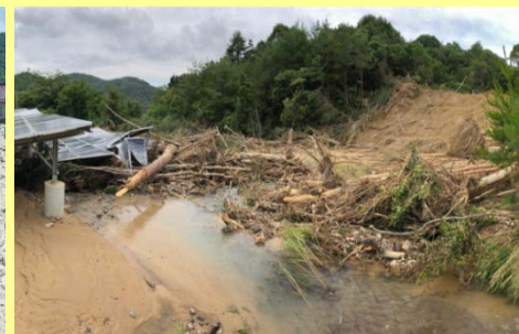
松板川(広島市西条町福本地先)
