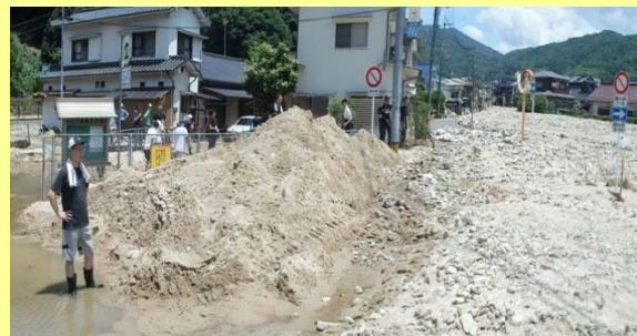
瀬野川左岸支川(安芸区瀬野西地先)
