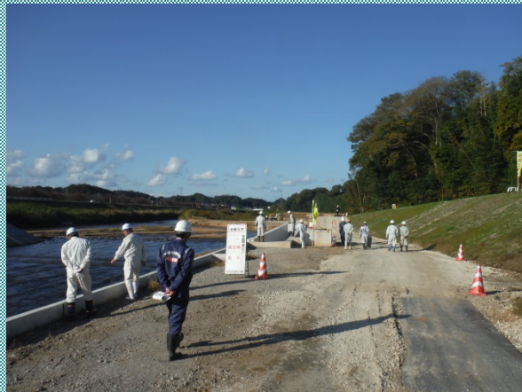
対象現場：法勝寺川青木地区護岸他整備工事
