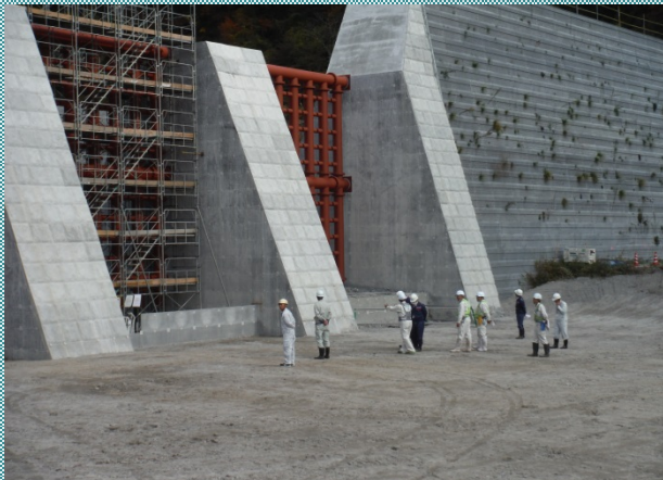
対象現場：大山砂防二の沢砂防堰堤第4工事
