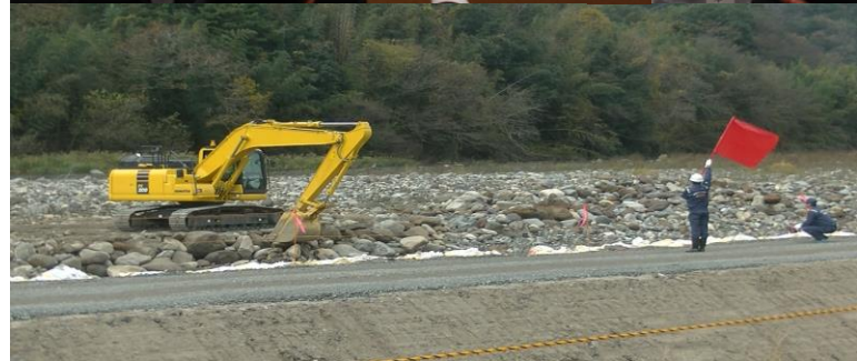
鍬入れで堤防整備工事に着手しました
