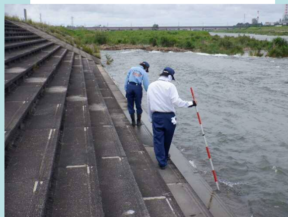
日野川堰親水階段水際部の点検
