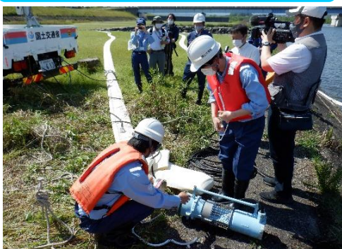
排水ポンプ 設置中!
