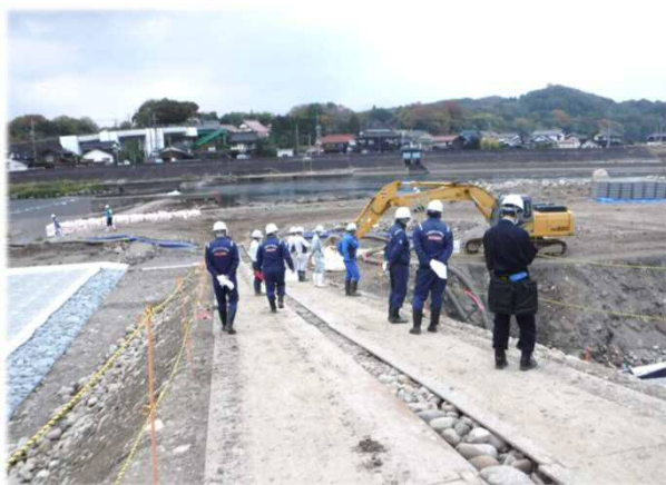
パトロール現場 日野川河道整備外工事
