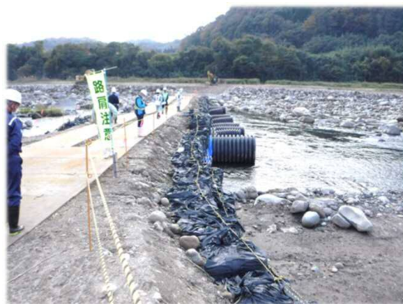
パトロール現場 日野川立岩地区河道掘削他第2工事
