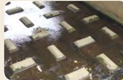
床止工（護床工）
