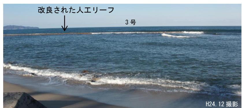
図 6.29 皆生工区の離岸堤と改良された人工リーフ
