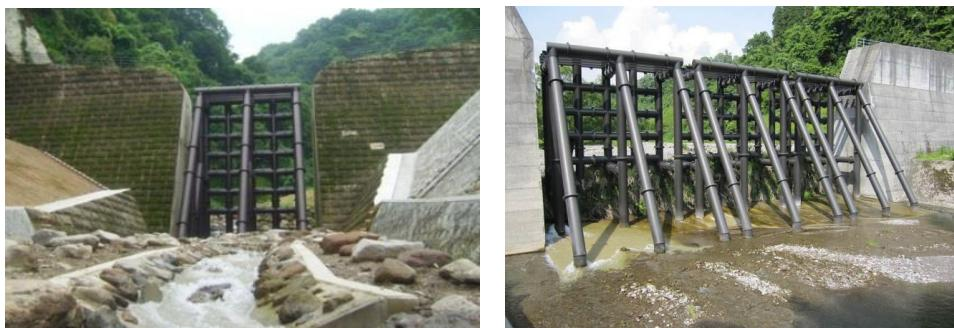
図 6.3 透過型砂防堰堤（左：大阪 4 号砂防堰堤、右：吉原砂防堰堤）
