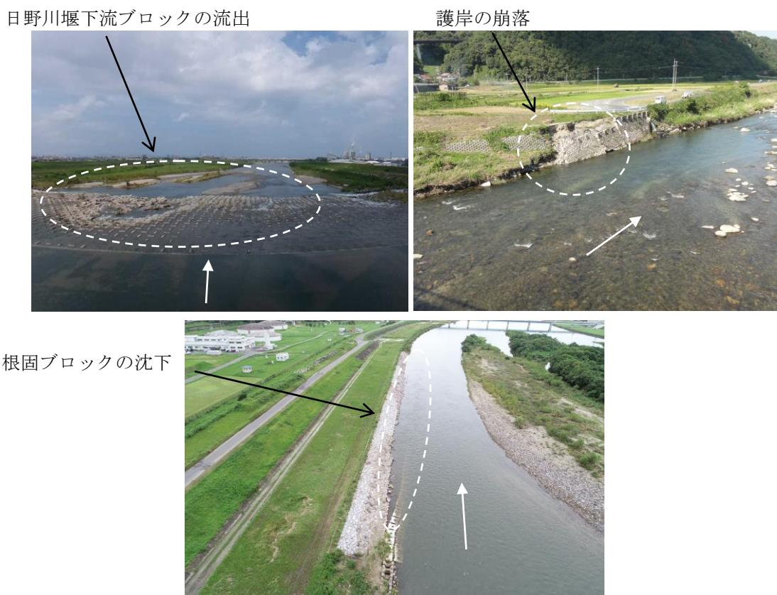
図 6.15 局所洗掘の進行と護岸災害の発生
