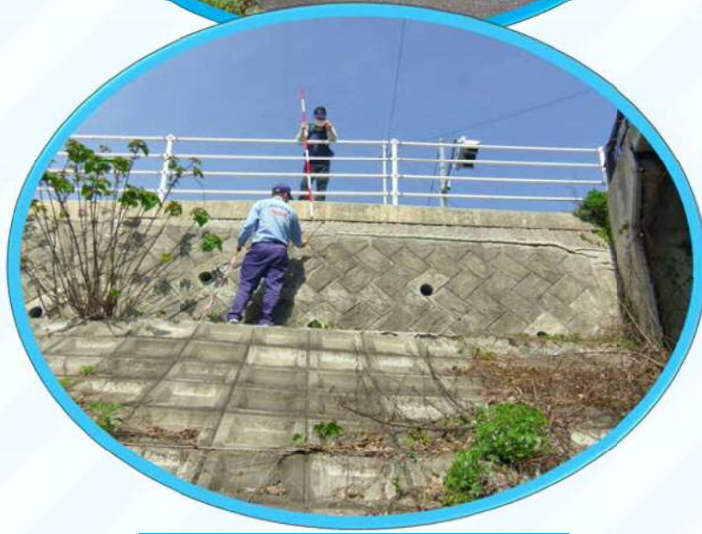
■点検実施状況
