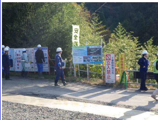
パトロール現場 令和4年度大山砂防添谷2号 砂防堰堤工事用道路第2工事
