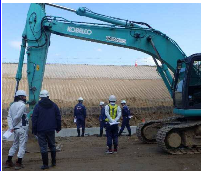
パトロール現場 令和4年度日野川吉定護岸外工事
