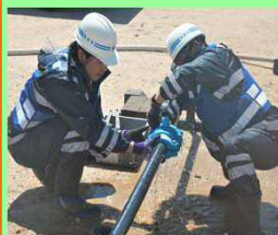
米子市水道局による 水道管補修訓練
