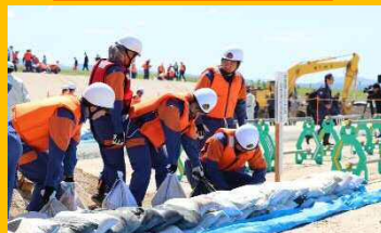
水防団による水防訓練 (改良積み土のう工法)
