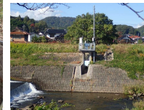
清水排水樋管
