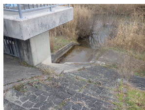
榎原排水樋門
