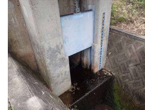
東安寺排水樋管
