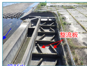
呼び水水路 魚道 整流板の設置状況 (上流側魚道)
