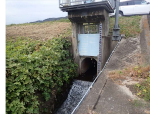
下瀬排水樋管
