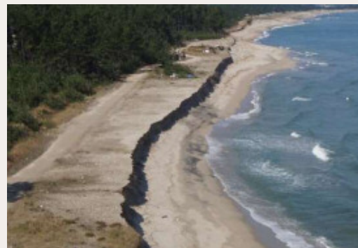
●海岸の侵食状況(富益地区)
