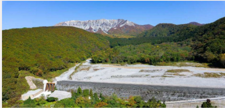
●三の沢砂防堰堤(小江尾川) 平成27年11月完成 * 三の沢砂防堰堤は、堰堤の長さ304mと中国地方最長の砂防堰堤です。
