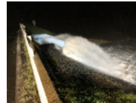
●洪水時の排水状況
