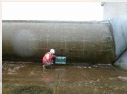
●日野川堰の点検保守
