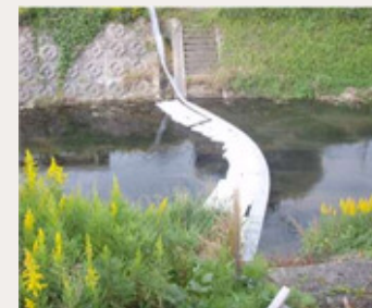
●オイルフェンス設置 (油流出事故対応)
