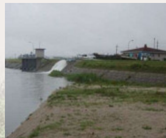
●皆生排水機場
