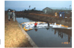
●オイルフェンスの設置
