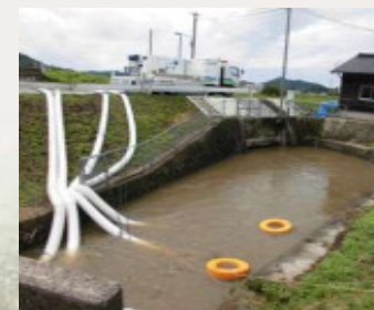
●排水ポンプ車の排水状況
