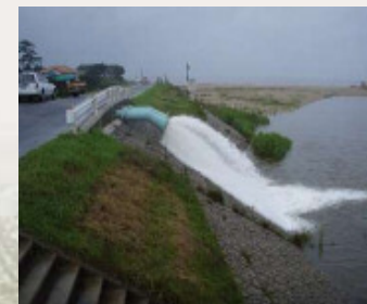
●皆生排水機場の洪水時排水状況
