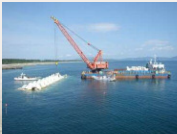
●離岸堤施工状況
