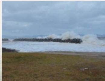
●離岸堤による消波状況(皆生地区)
