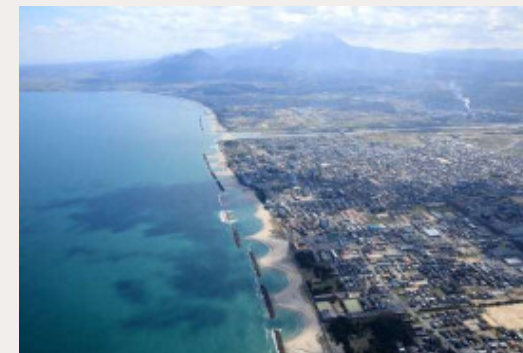
●離岸堤の施工状況(皆生地区)
