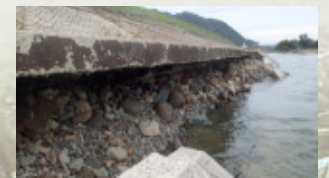
●中祖地先(被災状況)
