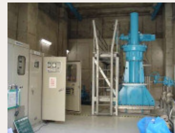
●新設した小規模バルブ
