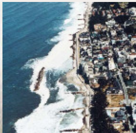
●昭和46年当時の風景 (1号離岸堤完成時)
