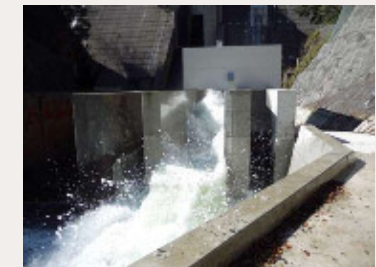
●小規模バルブによる10m 3 /sの放流
