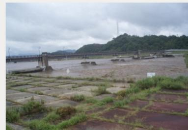
●日野川堰の洪水時倒伏操作
