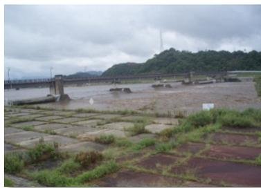
日野川堰の洪水時倒伏状況
