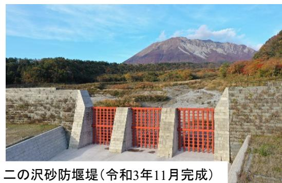
透過型砂防堰堤の例
