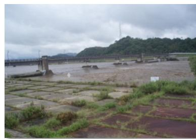
日野川堰の洪水時倒伏状況
