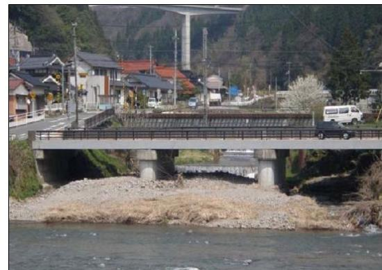
日野川合流点で流出土砂が堆積(小江尾川)
