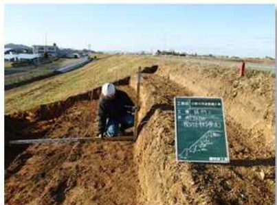
河川工事の監督
