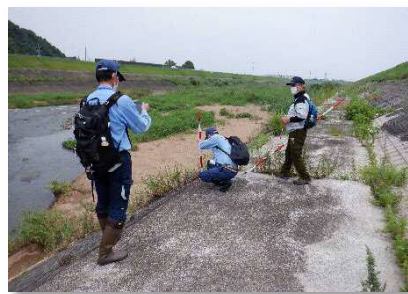
職員による堤防等の点検
