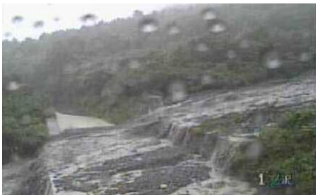
平成23年9月3日 環状道路への土砂流出状況(一の沢)
