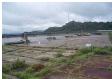
日野川堰の洪水時倒伏状況
