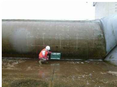
日野川堰の点検保守
