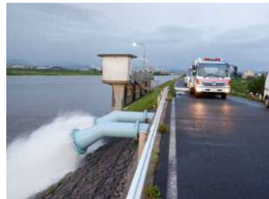
皆生排水機場(救急内水対策)の排水作業
