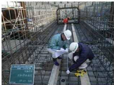
河川工事の監督
