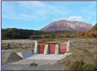
二の沢砂防堰堤 (令和3年11月完成)
