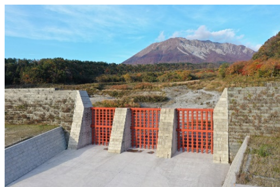
透過型砂防堰堤の例
