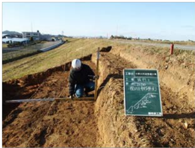
河川工事の監督
