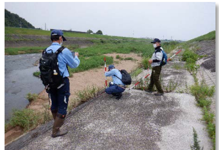
職員による堤防等の点検
