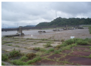
日野川堰の洪水時倒伏状況
