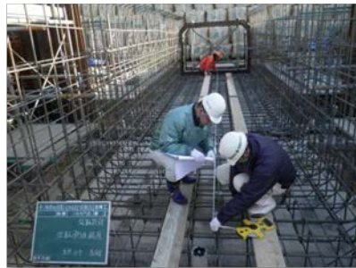
河川工事の監督
