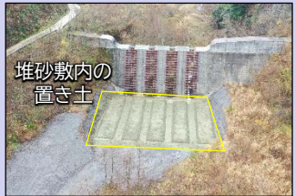
一の沢砂防堰堤の置き土
