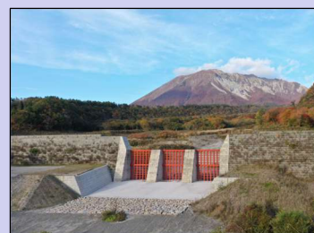
二の沢砂防堰堤（令和3年11月完成）
