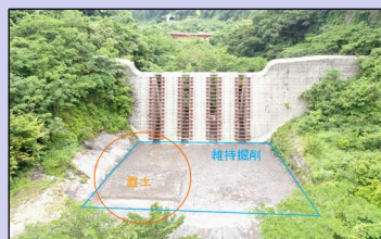
一の沢砂防堰堤の置き土
