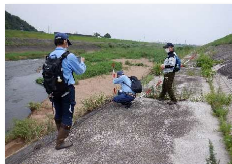
職員による堤防等の点検
