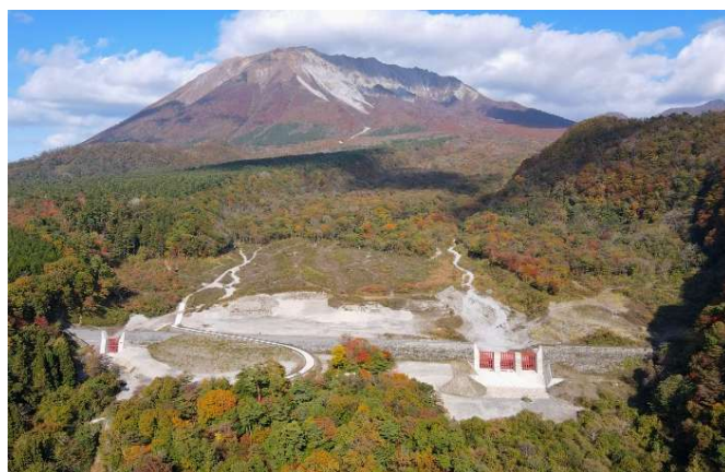
二の沢砂防堰堤 (大山砂防最大の砂防堰堤) (令和3年11月に完成)
