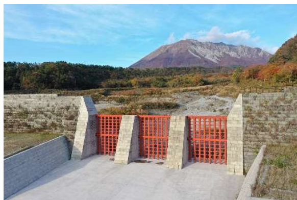
透過型砂防堰堤の例
