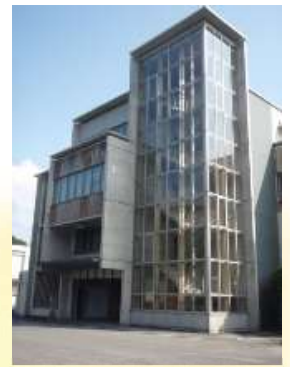
菅沢ダム管理支所
