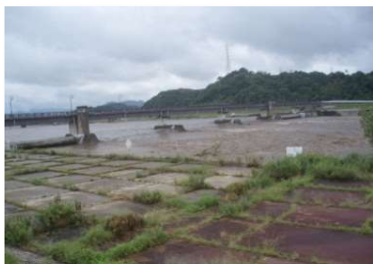
日野川堰の洪水時倒伏状況
