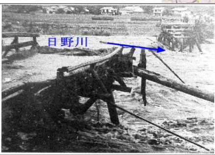
江府町 洲河崎橋梁の落橋 昭和20年9月 枕崎台風 床上浸水445戸、床下浸水1,802戸
