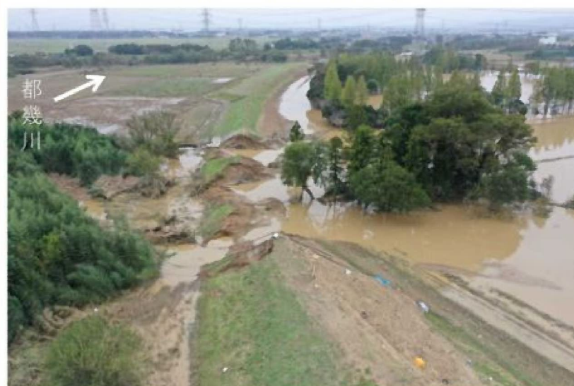
都幾川0.4k右岸 決壊箇所
