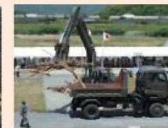
流木撤去訓練
