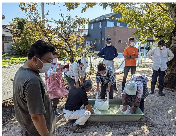
吸水土のう作成 (水につけて作成)
