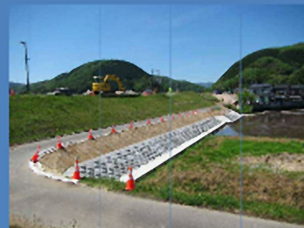
西城川 左岸 寺戸地区 施工状況
