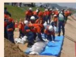
改良積土のう工法
