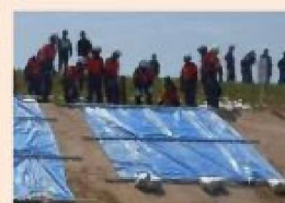
シート張り工
