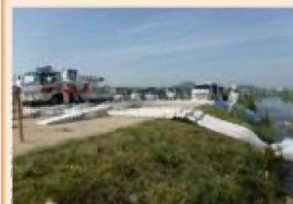
TEC-FORCEによる 緊急排水活動訓練
