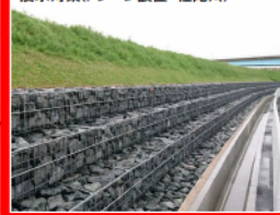
浸水対策(ドレーン設置 佐陀川)
