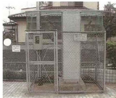
観測装置設置状況
