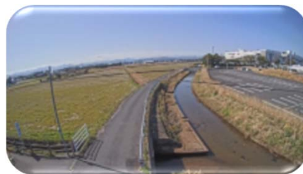
②海川排水路イオン日吉津東側
