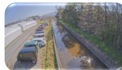
④箕蚊屋排水路王子製紙北側
