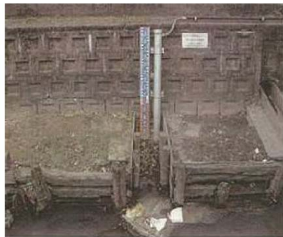
水位計設置状況
