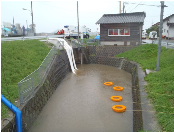
例：ポンプ排水時の窠場
