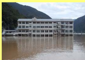
H26.8避難所2階の浸水 (徳島県)
