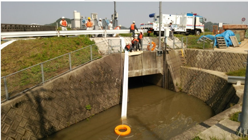
例：排水ポンプ車設営訓練状況
