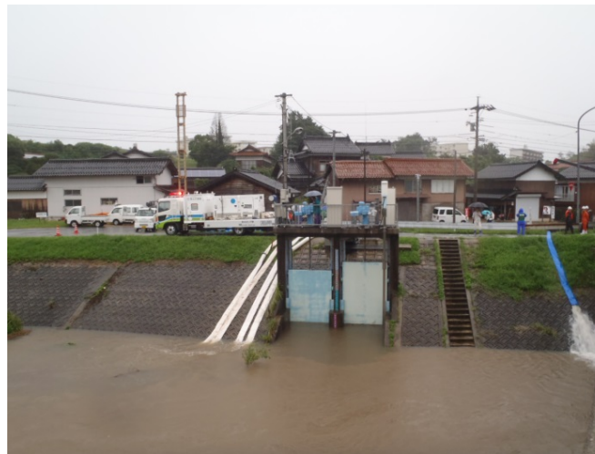
例：排水ポンプ車運転状況（平成25年9月）
