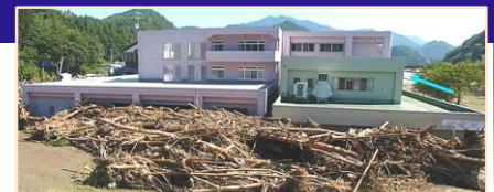
平成28年台風10号により、岩手県のとて要配慮者利用施設では利用者9名の全員が死亡。
