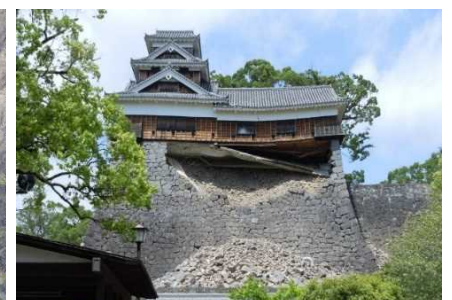
熊本城の被害
