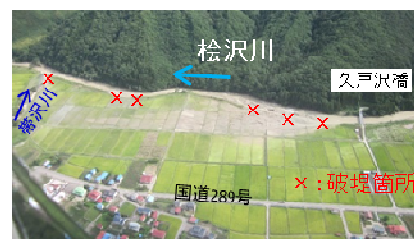
背後地への浸水状況
