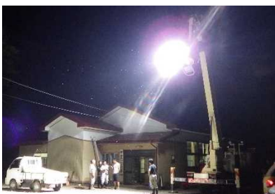
停電した避難所の夜間照明確保
