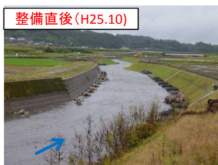
既設護岸保護のための根固め ブロックをとびとびに据え付け
