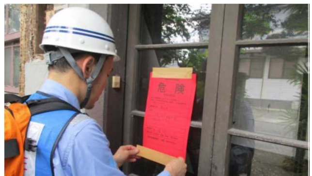
被災家屋の応急危険度判定
