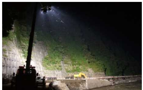
岩手県岩泉町における道路啓開
