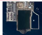
海面処分場における災害廃棄物の最終処分
