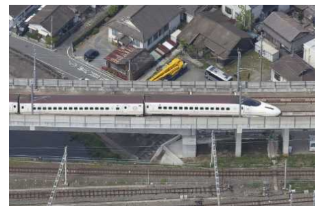
新幹線脱線(熊本駅南側)
