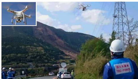
阿蘇大橋地区での被害状況調査(南阿蘇村)
