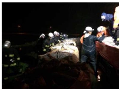
積み土のう工による越水防止 北海道音更町 十勝川(8月30日)
