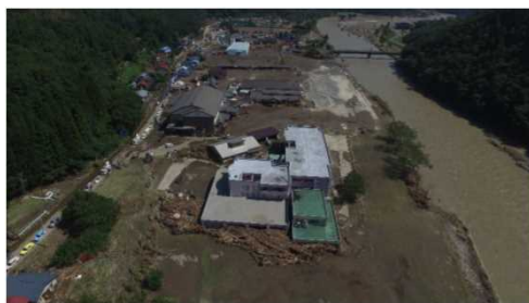
ドローンによる浸水被害調査(岩泉町)
