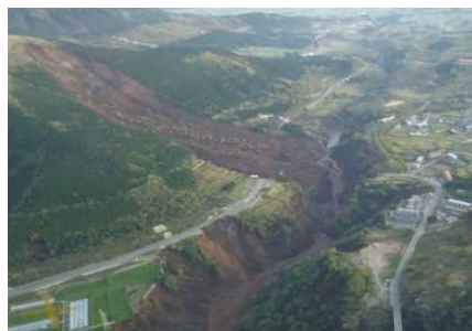
斜面崩壊による道路、鉄道の寸断
