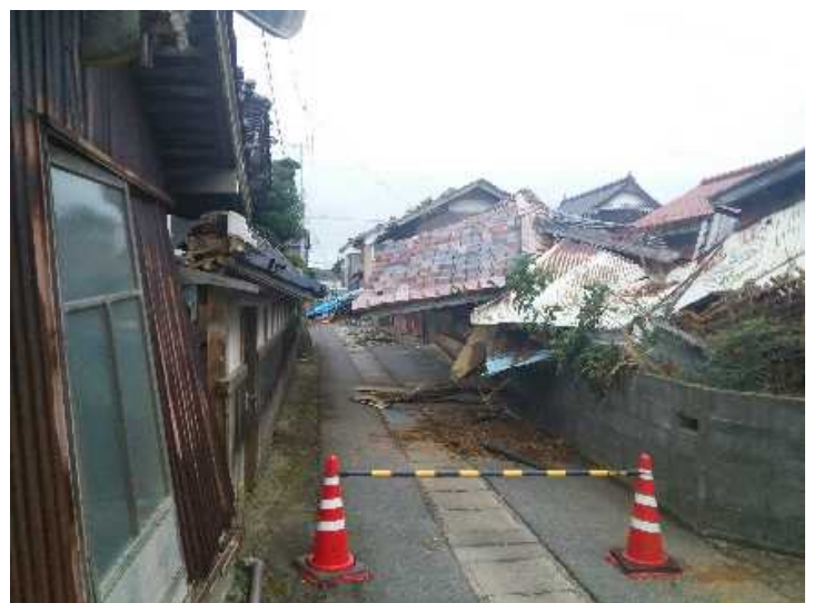
家屋の被災状況(鳥取県北栄町)
