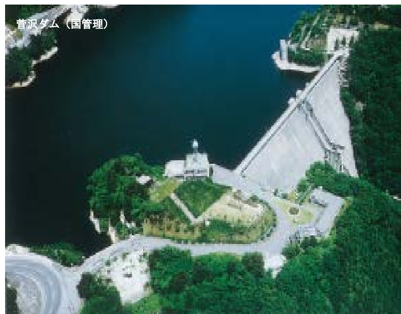
菅沢ダム(昭和43年度完成)
