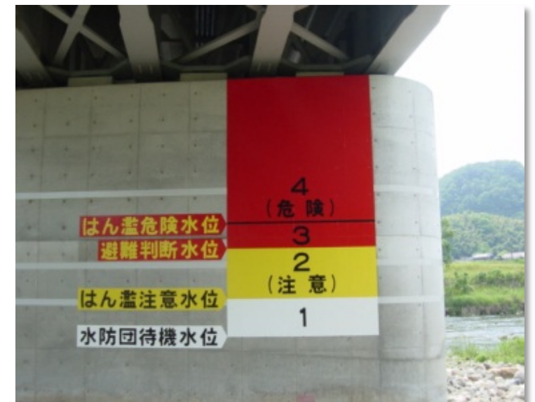
水位標示の設置例 日野川の鬼守橋
