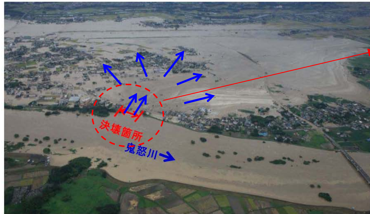
被災状況(全景写真)
