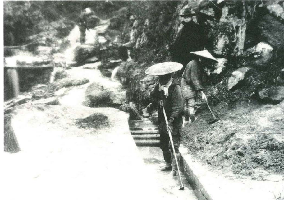
掘り起こした土を水路に流し、 砂と砂鉄を分別している様子
