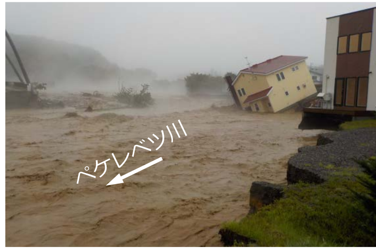
台風第10号の影響により護岸がけずられる (十勝川水系ペケレベツ川)
