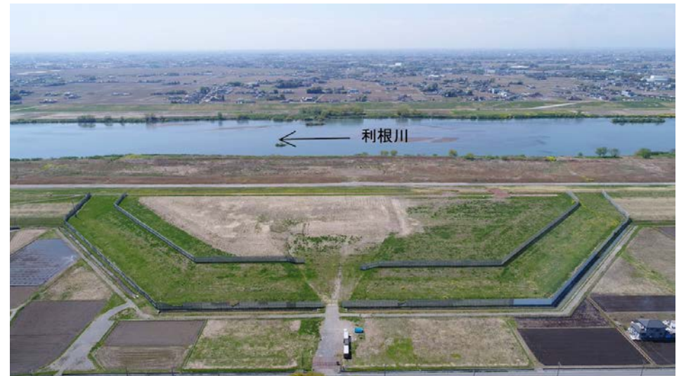
栄地区広域避難地(埼玉県加須市)
