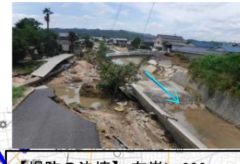
【堤防の決壊】左岸L=200m 右岸L=300m 末政川左右岸0k700付近(県)
