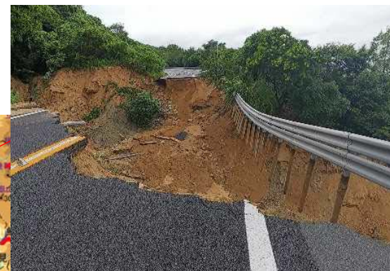
広島県道路 坂南IC～天応西IC(広島県安芸郡坂町)
