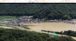
【堤防の決壊】L=100m 真谷川左岸0k300付近(県)
