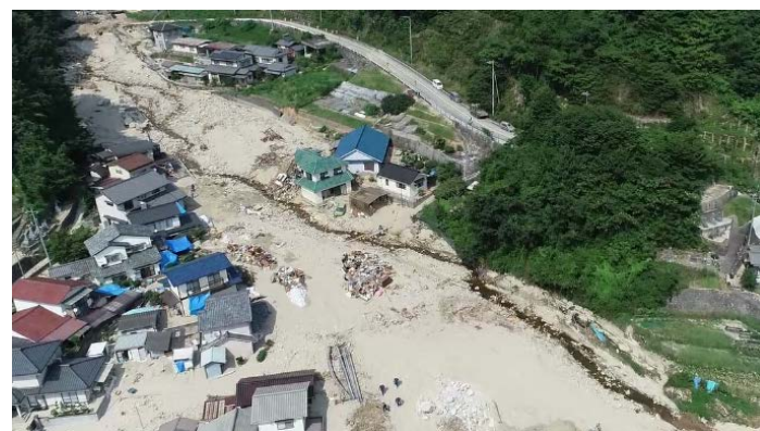
土砂・洪水氾濫(今次洪水)
