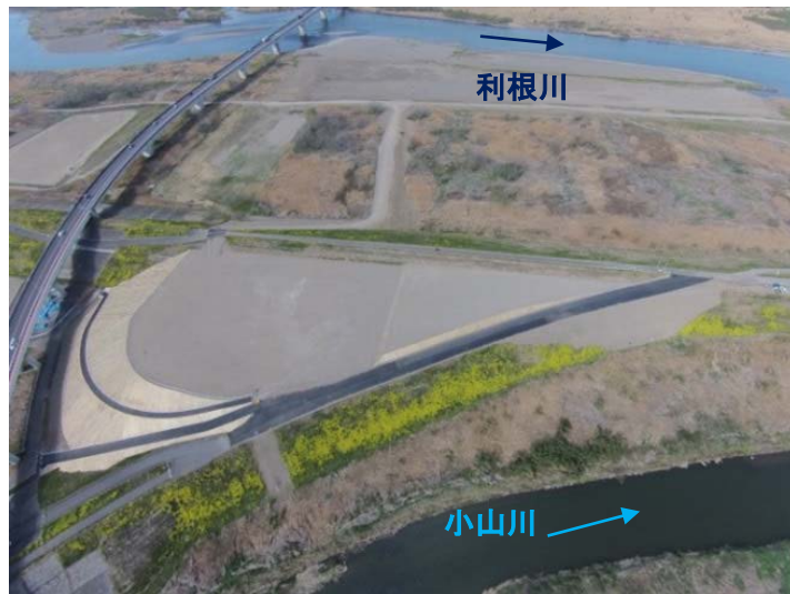
下高島地区(埼玉県深谷市)
