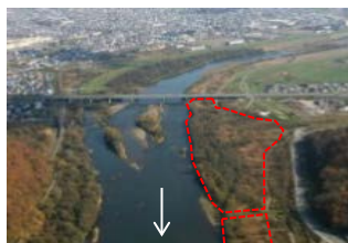
・河道掘削や樹木伐採
