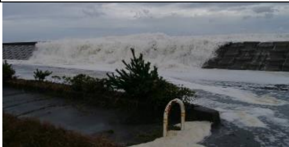
高潮による堤防越波状況
