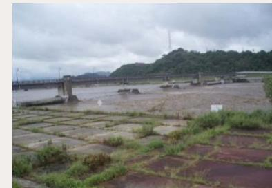
●日野川堰の洪水時倒伏操作
