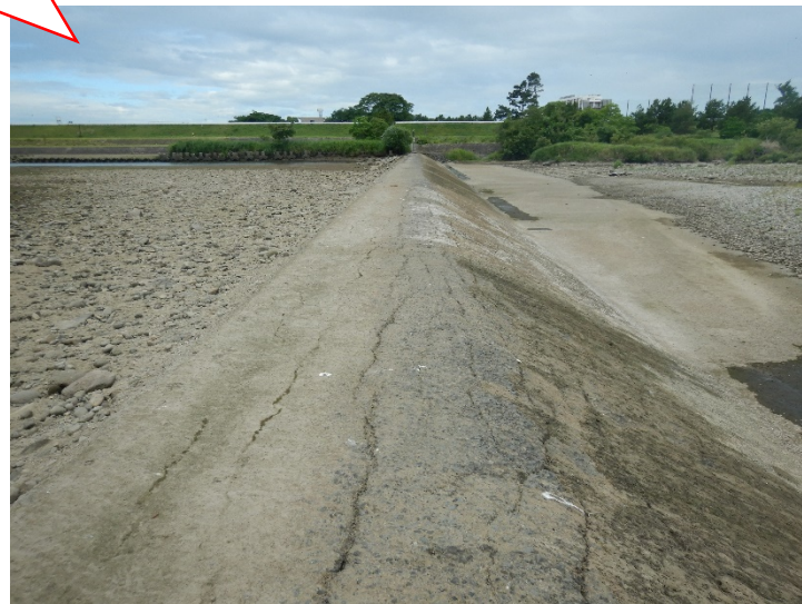
中央魚道より 左岸側
