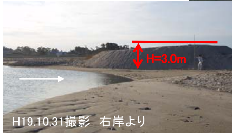
河口砂州の開削部の状況
