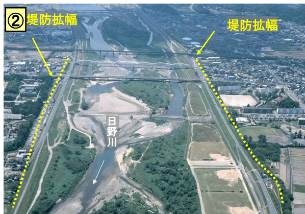
車尾地区の一連堤防
