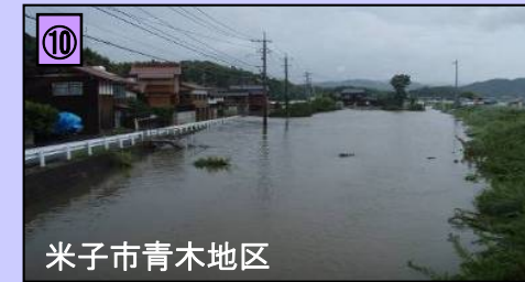
平成23年9月洪水による内水被害状況
