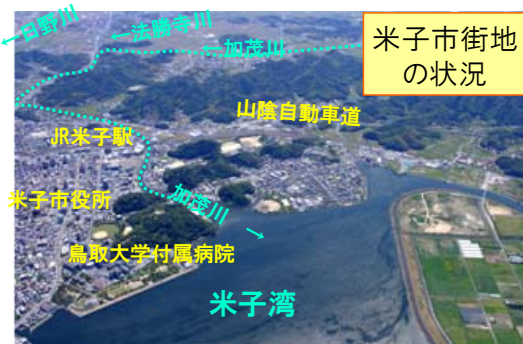
はん濫原の重要な公共施設
