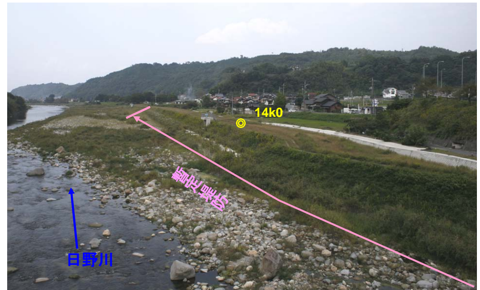
華翠橋下流（右岸）の状況
