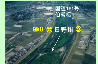
日野川9.0k(伯耆町岸本付近)の斜め写真(H17.6撮影)
