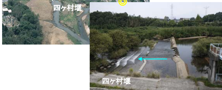
戦後最大流量に対する流下能力不足区間に位置する代表的な固定堰
