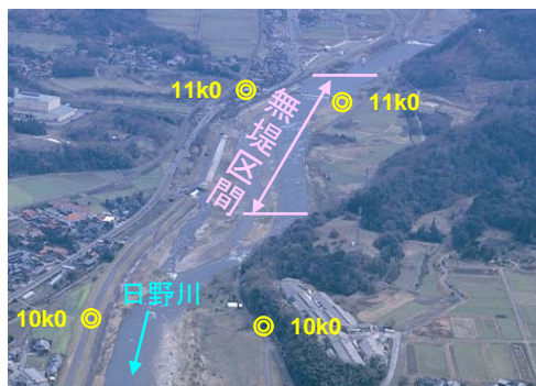
日野川の無堤区間
