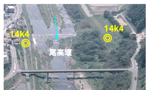
戦後最大流量に対する流下能力不足区間に位置する固定堰
