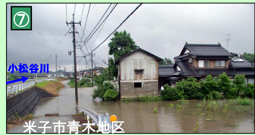
平成18年7月洪水による内水被害状況
