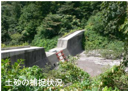
砂防堰堤の堆砂状況
