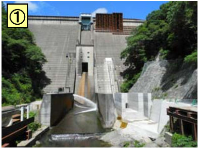
①【菅沢ダム】 目的:洪水調節、かんがい、工水、発電 完成年:昭和43年 管理者:国土交通省
