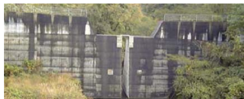
既設砂防堰堤のスリット化(袋原砂防堰堤)
