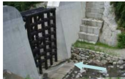
大坂4号砂防堰堤(鋼製スリット)
