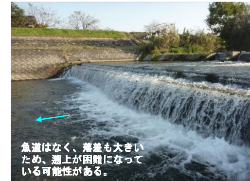
四ヶ堰(法勝寺川)の状況
