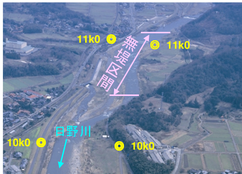
日野川の無堤区間
