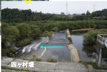
戦後最大流量に対する流下能力不足区間に位置する代表的な固定堰
