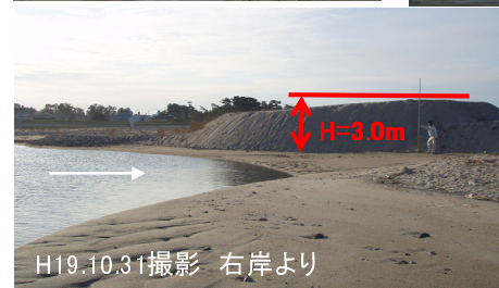
河口砂州の開削部の状況
