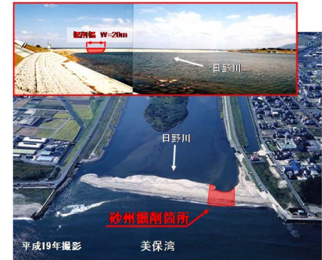
河口砂州の維持掘削
