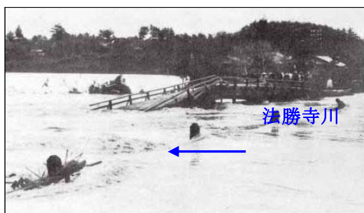
大正 7 年 9 月洪水により落橋 (米子市：法勝寺川兼久橋) 出典 『日野川河川事務所のあゆみ』 (日野川河川事務所)
