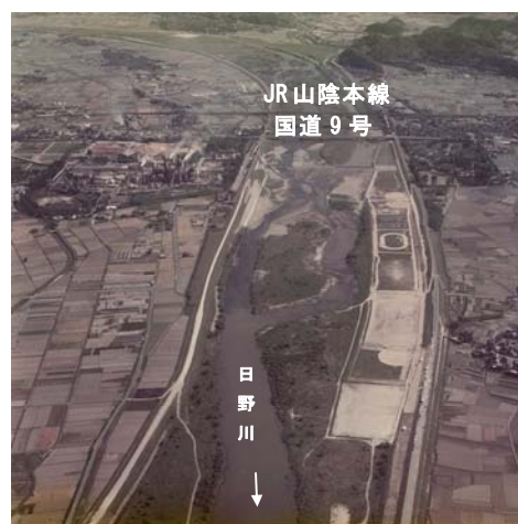
昭和57年撮影(堤防拡幅前)
