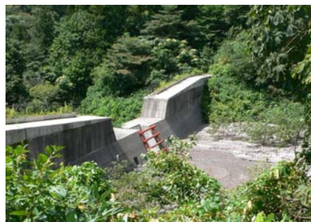
33 砂防堰堤の堆砂状況
