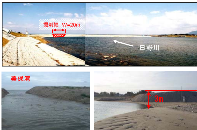
出水前の砂州の掘削の状況
