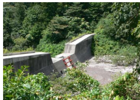
砂防堰堤の堆砂状況
