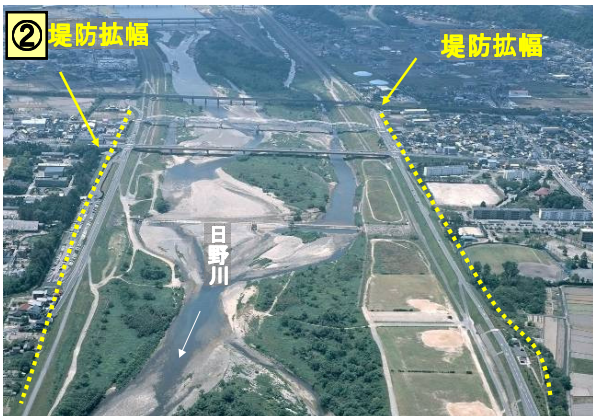
車尾地区の一連堤防
