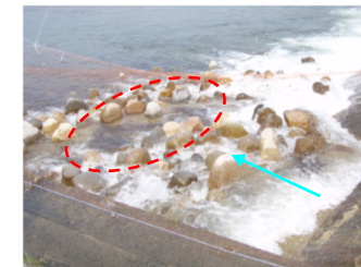
車尾床止左岸の魚道(黒い影はアユの遡上である)
