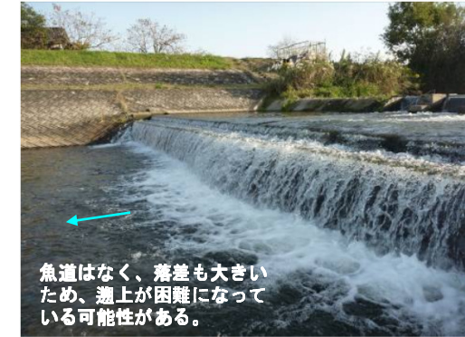
四ヶ堰(法勝寺川)の状況
