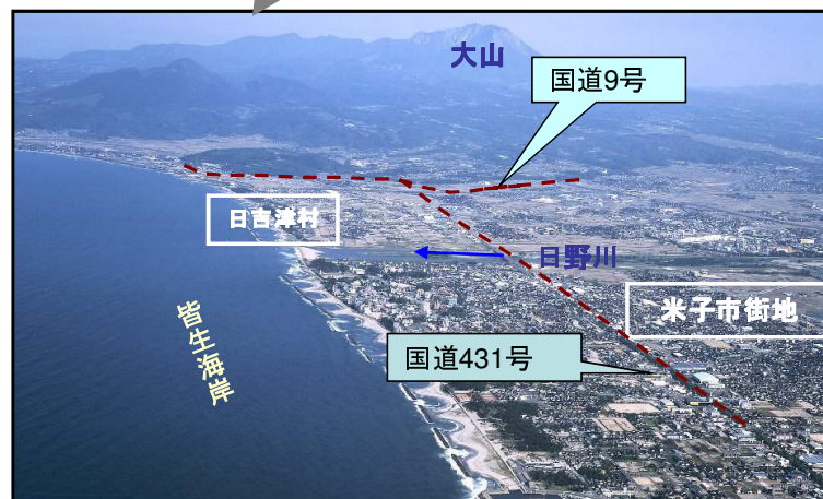
下流部の状況 (日野川左岸米子市側から望む)
