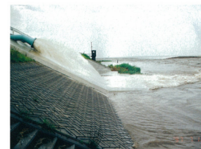
皆生救急内水対策ポンプによる排水状況
