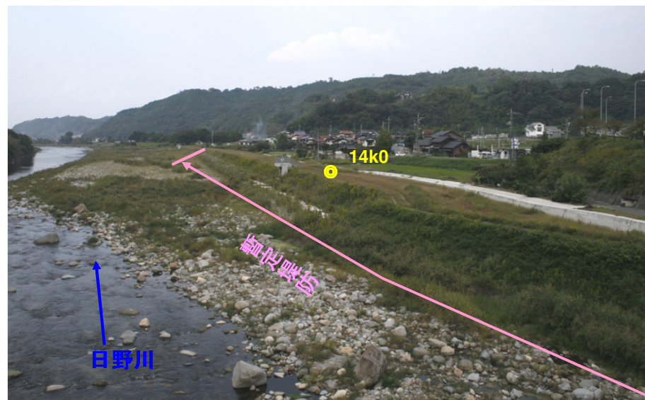
華翠橋下流（右岸）の状況
