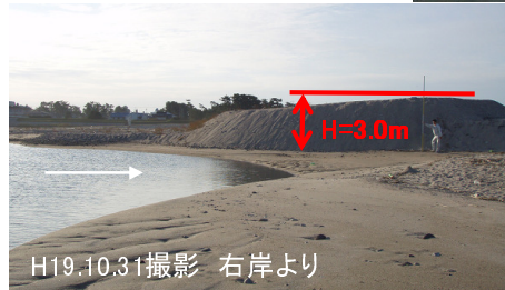
河口砂州の開削部の状況
