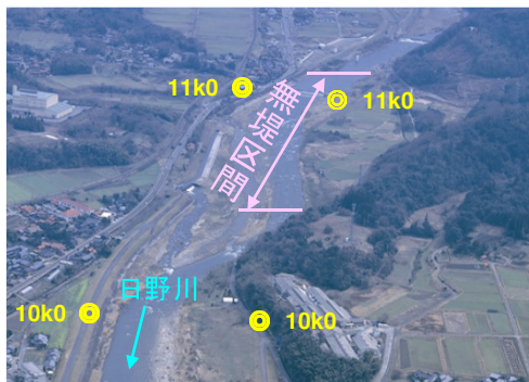
日野川の無堤区間
