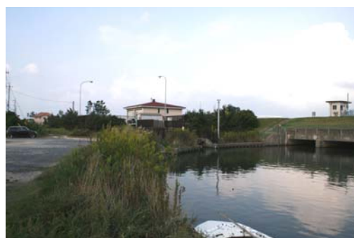
皆生救急内水施設
