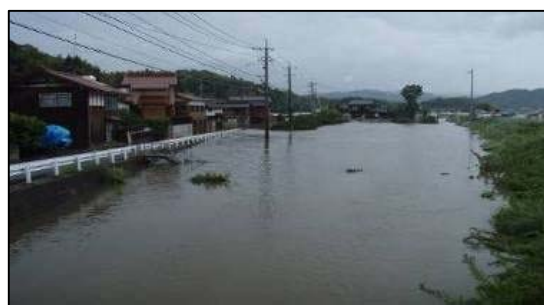
米子市青木地区(内水被害状況) 平成 23 年 9 月洪水の状況
