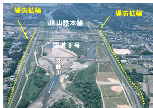
平成18年撮影（堤防拡幅後）
