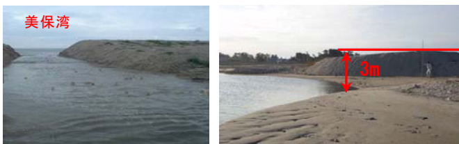
出水前の砂州の掘削の状況
