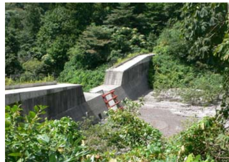
32 砂防堰堤の堆砂状況
