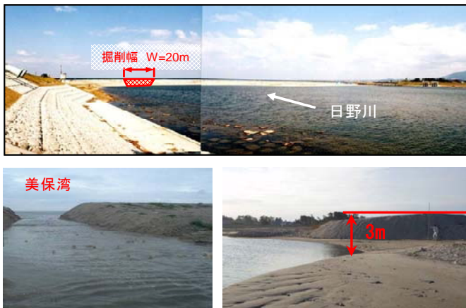
出水前の砂州の掘削の状況
