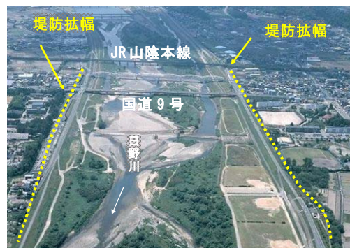
平成18年撮影（堤防拡幅後）
