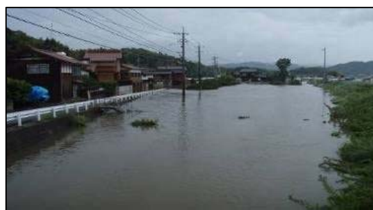
米子市青木地区(内水被害状況) 平成23年9月洪水の状況
