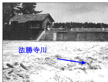
昭和 9 年 9 月洪水による法勝寺川の濁流 出典 『日野川今昔写真集』(立花書院)
