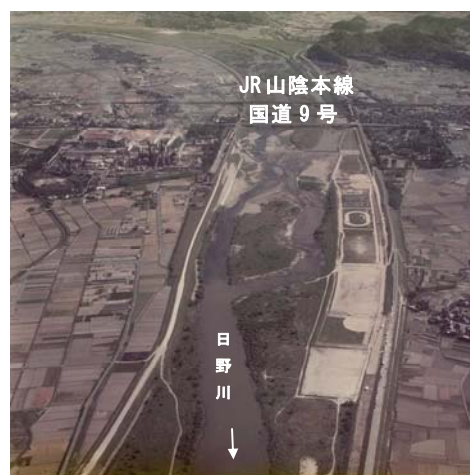
昭和57年撮影（堤防拡幅前）
