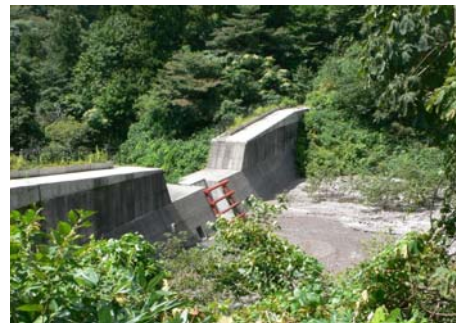
砂防堰堤の堆砂状況
