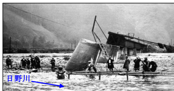
昭和 9 年 9 月洪水により落橋 (日野町根雨付近；第三日野川根雨鉄橋) 出典 『日野川河川事務所のあゆみ』 (日野川河川事務所、日野町公民館)
