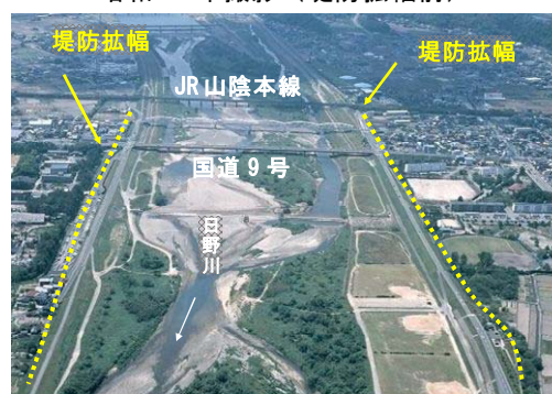
平成18年撮影（堤防拡幅後）
