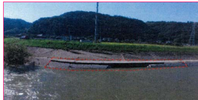
低水護岸の崩落(日野川16k900付近、伯耆町中祖地先)
