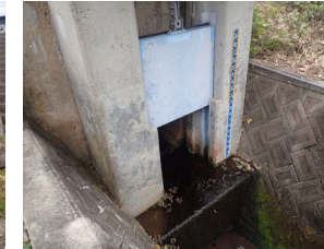
東安寺排水樋管
