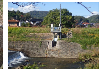
清水排水樋管
