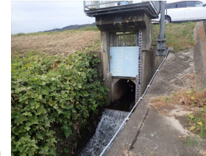
下瀬排水樋管
