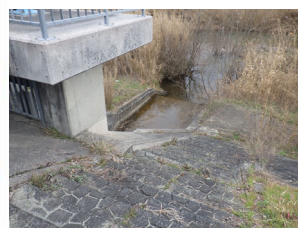
榎原排水樋門
