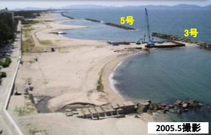
離岸堤施設改良前後の状況
