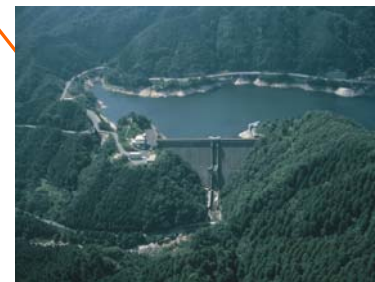
菅沢ダム(国土交通省管理・昭和 43 年完成) [洪水調節、かんがい用水、工業用水、発電] 出典：日野川河川事務所
