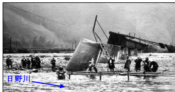
昭和 9 年 9 月洪水により落橋 (日野町根雨付近；第三日野川根雨鉄橋) 出典 『日野川河川事務所のあゆみ』 (日野川河川事務所、日野町公民館)
