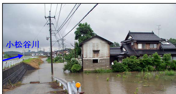
米子市青木付近：洪水による浸水 平成 18 年 7 月洪水の状況
