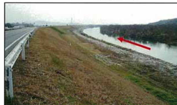
堤防強化工事 着手前状況
