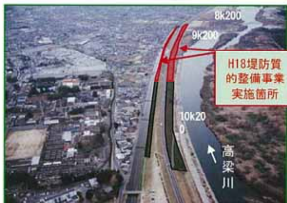
対策工の整備箇所
