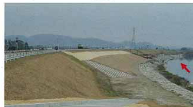
堤防強化工事 完成状況
