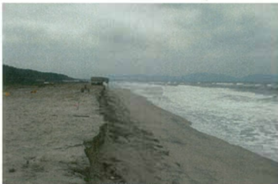
海岸侵食が進む夜見富益工区(H18.12.8撮影)
