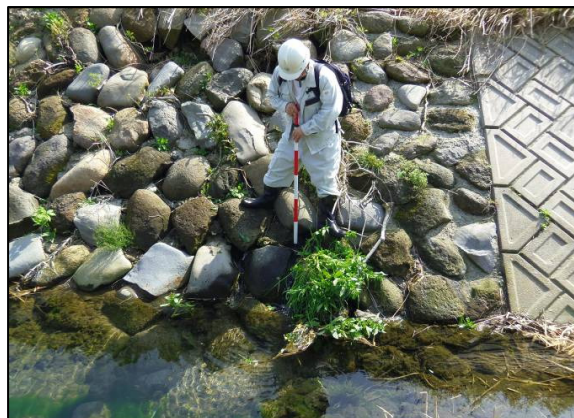
点検実施状況写真
